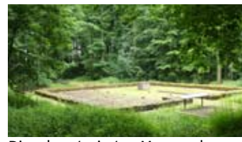
Die rekonstruierten Mauern des Kleinkastells Holzheimer Unterwald
